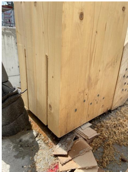
Dubbla ingjutningsgods ska träffas med genomgående dymling
